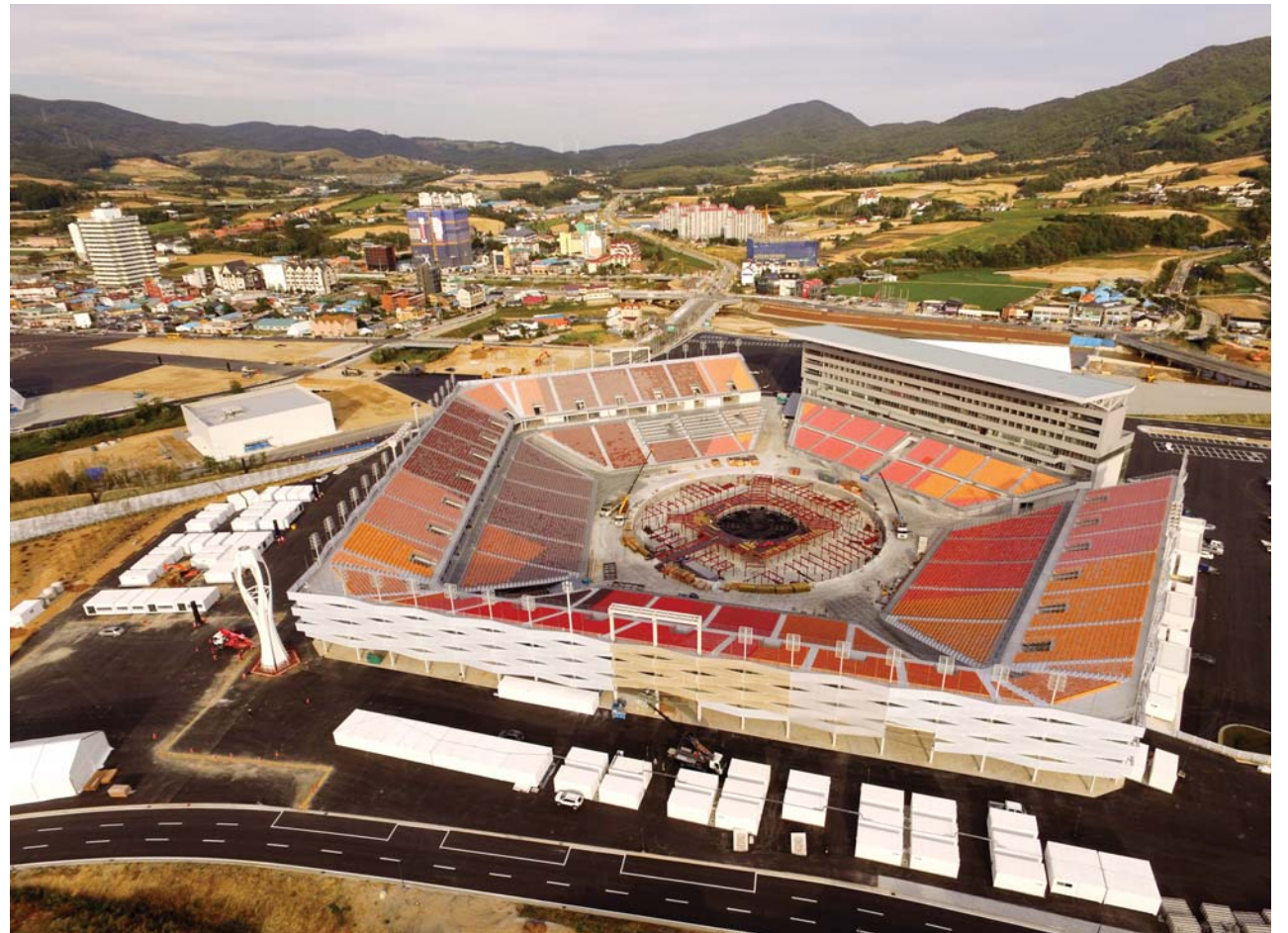
강원 평창군 대관령면 황계리에 지어진 평창 올림픽 플라자가 위용을 드러내고 있다. 올림픽 최초 행사 전용 개·폐회식장이자 24만㎡ 부지 내 지하 1층 지상 7층의 철골 및 철근콘크리트 구조로 5만8790㎡의 연면적(건축면적 2만6300㎡)에 3만5000석의 가변석을 갖췄다. 무대는 직경 72m의 원형으로 공연에 용이하게 건설됐다.
