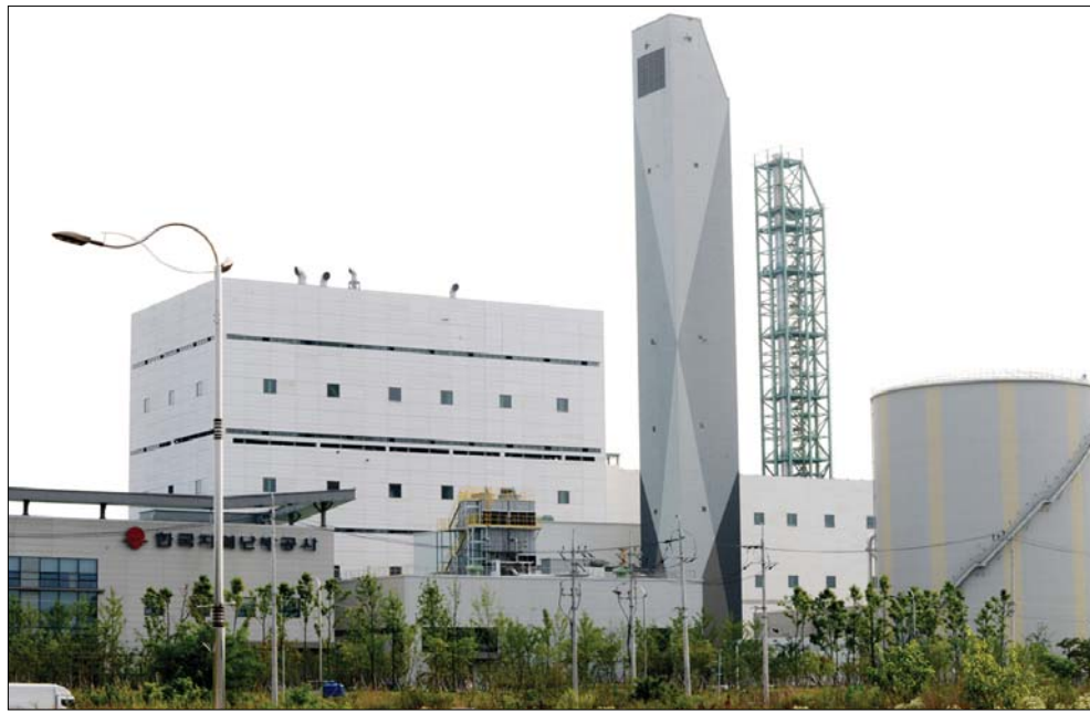
4일 조건부 건축물 사용 승인 허가가 난 나주혁신도시 SRF 열병합발전소.
