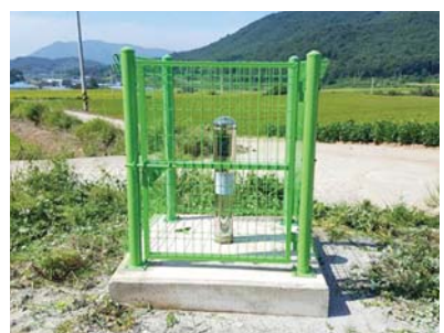
지하수 수량과 수질관리를 위해 설치한 지하수 관측공.
