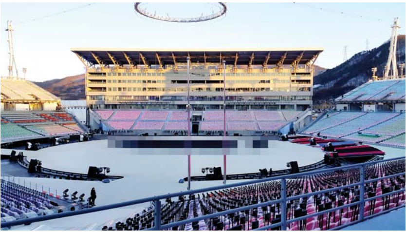
방풍막이 설치된 개폐회식장의 모습. 여전히 지붕은 없다. 대관령의 실리적인 칼바람에 노출되어 있어 관객이 4~5시간 동안 바람과 맞서야 한다.
