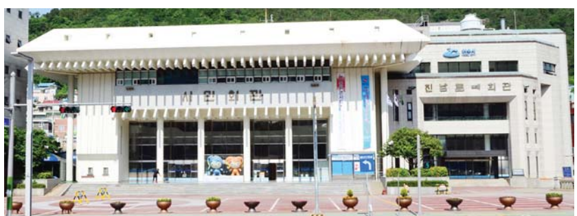
여수 시민회관과 진남문예회관이 노후 시설물 보수 관계로 임시 휴관
