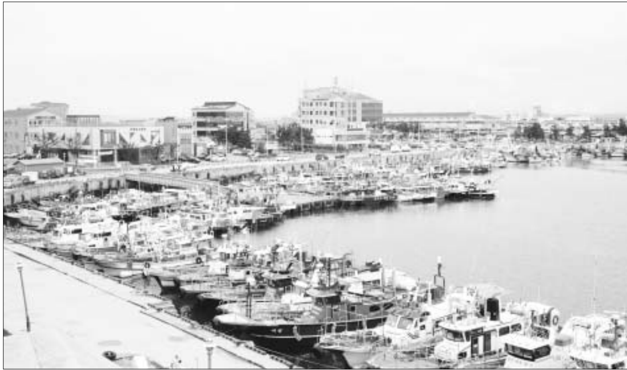
부두에 묶인 배 9일 전북 군산시 이청도 배 전복 사건과 을씨년스러운 장마의 날씨 때문에 군산 비응항의 부두가 출항하지 못한 배들로 가득 차 있다.
