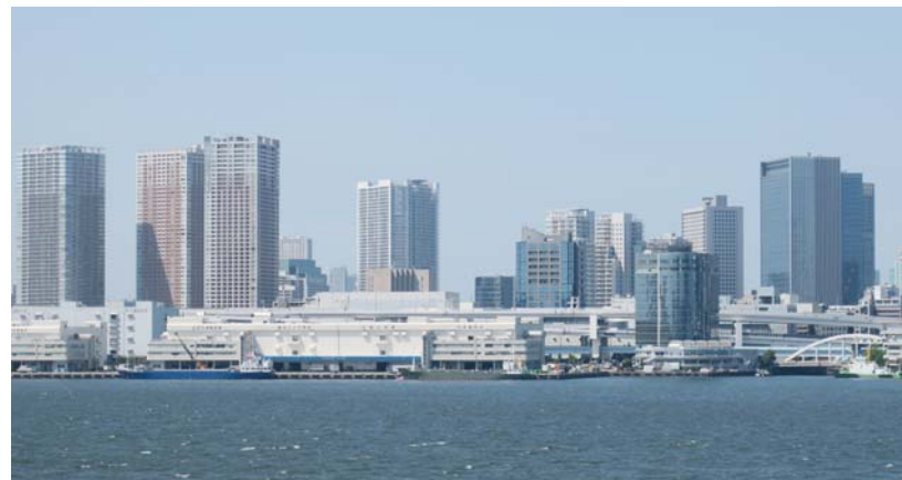
현재 공사중인 2020년 도쿄 올림픽 선수촌은 도심에 위치해 있으며 도쿄 제일 번화가중 하나인 긴자(銀座)까지도 바로 연결된다. 도쿄타워를 비롯한 도쿄의 도심아경도 볼 수 있다. 선수촌 공사현장에서 바라본 도쿄 도심 풍경.
