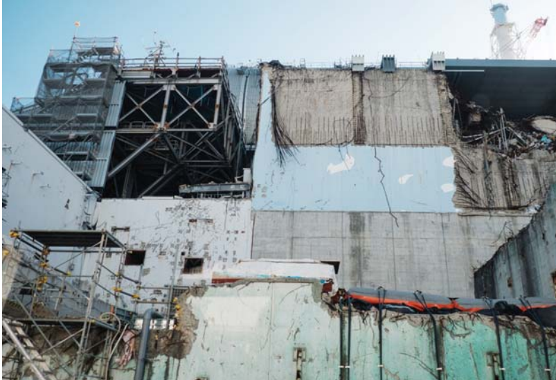
후쿠시마 제1 원전에는 수소폭발로 떨어져 나간 원자로 벽의 일부가 그대로 남아있는 등 2011년 후쿠시마 원전 사고의 상흔이 7년이 지난 지금도 여전히 남아 있다.
