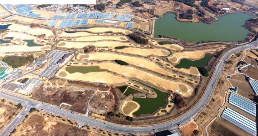
나주혁신도시 한전공대 부지
