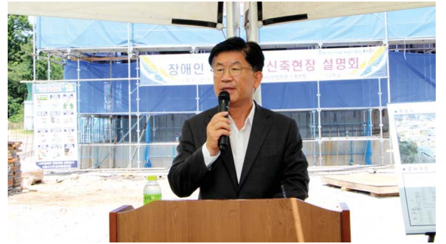
21일 나주시에 따르면 지역 장애인들의 오랜 숙원인 '장애인 연합회관'이 송월동 일대에 총사업비 55억원을 투입, 8860㎡(2680여평) 부지에 연면적 1943㎡(587여평), 지상 3층 규모로 오는 12월 준공 예정이다. 사진은 최근 신축공사 현장을 방문해 추진 상황을 점검한 강인규 나주시장.
