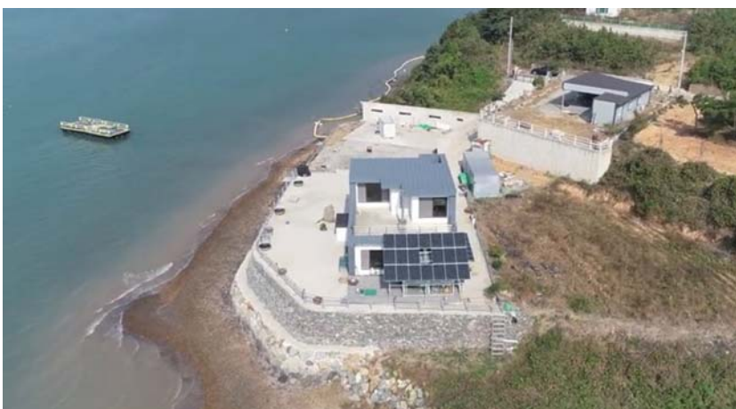
공유수면 100평을 불법 매립하고 석축을 쌓아 지은 무안군 삼향읍의 한 주택.
