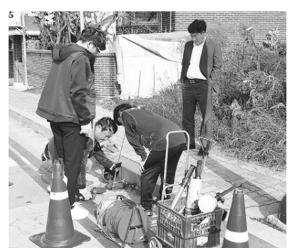
지하시설물 전산화 작업 모습
