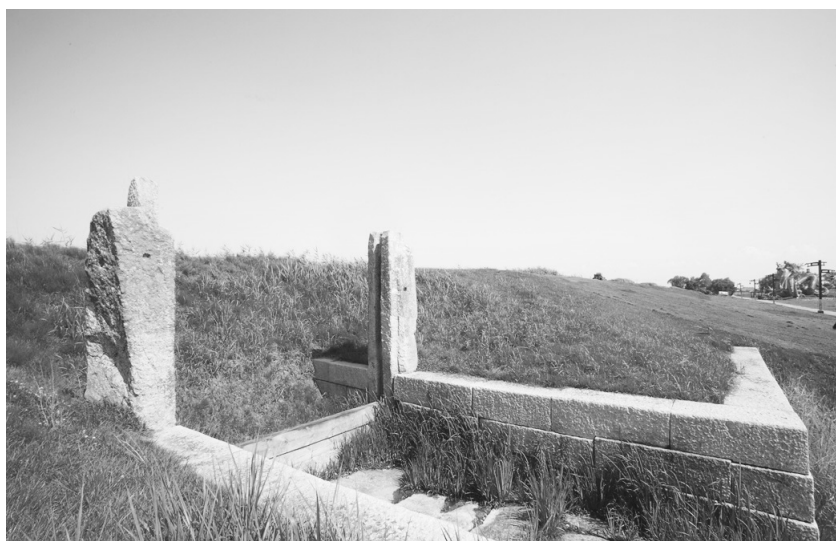
전북 김제 벽골제에서 내부의 도수로와 외부 경작지로 공급하는 대규모 도수로가 확인됐다. 김제시는 전라문화유산연구원
