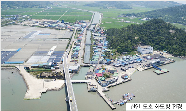
신안 도초 화도항 전경
