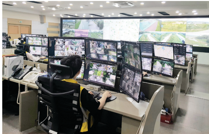
광주 CCTV통합관제센터 상황실.
