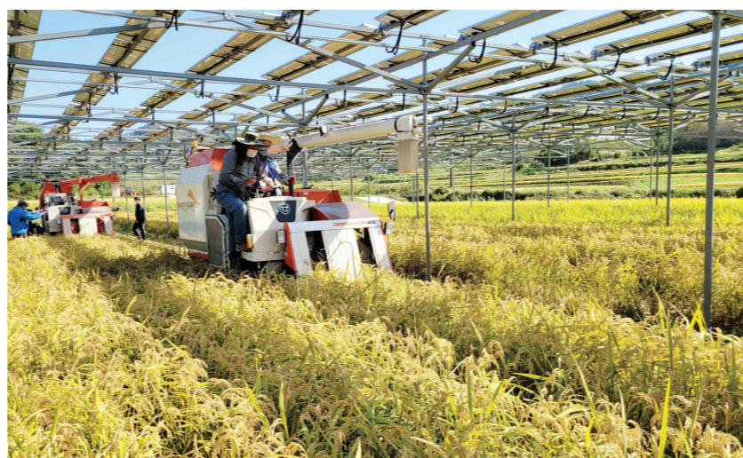
전남도농업기술원이 개발한 영농형 태양광발전시설. (사진=농업기술원 제공)
