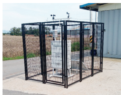
벽시간대에 즉시 대응이 가능하다. 군은 앞으로 악취발생 빈도와 민원 해소 추이 등을 분석해 설치 위치를 이통해 점검할 방침이며, 특히 악취 민
