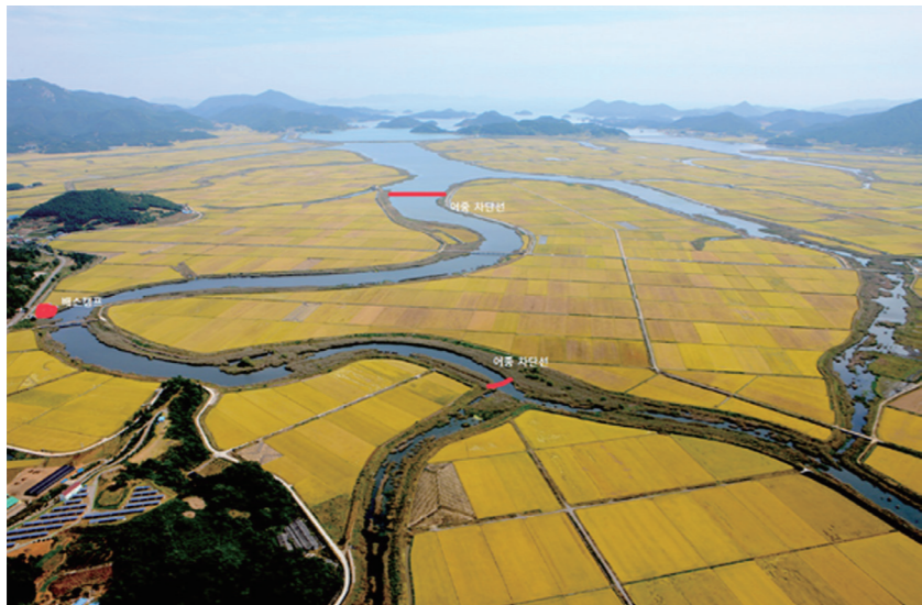
전남 고흥군해창만수상태양광발전소 건설 사업이 추진되고 있는 해창만 들녘. 고흥군 해창만 수상 태양광발전소 반대대책위원회(위원장 박동해)는 9일 지분 22% 주민 참여형해창만수상태양광 사업의 전면 재검토를 요구했다.
