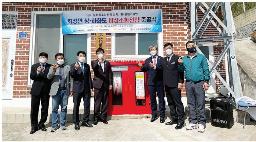
여수시가 4개 기관과 민·관협력사업으로 화정면 상화도 마을회관과 하화도 상하도 보건진료소 2개소에 비상소화전함 설치를 마쳤다고 8일 밝혔다.
