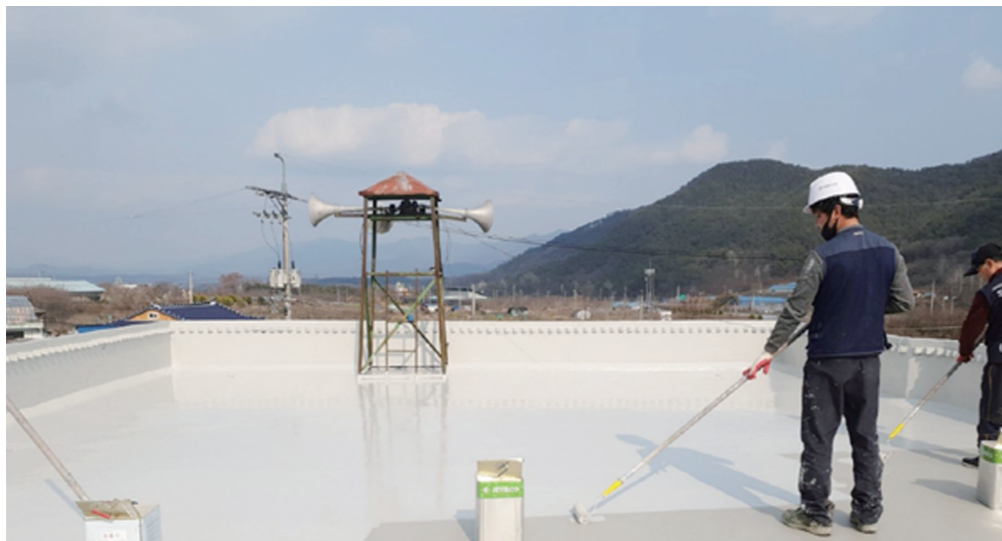
곡성군이 취약계층 폭염 피해를 줄이고자 읍면 무더위쉼터 57개소에 쿨루프 조성사업을 추진했다고 밝혔다. 쿨루프(cool roof) 사업은 건물 지붕이나 옥상에 태양광을 반사하거나 태양열
