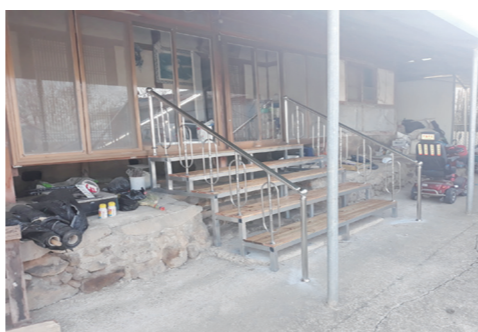
장애인주택개조사업 추진으로 장애인 경사로, 계단 및 안전봉 등이 설치 완료된 모습
