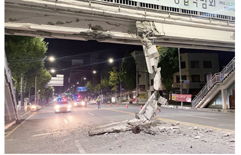
지난 18일 오전 4시30분께 광주 북구 북동 모 초등학교 앞 육교에 건설 중장비인 집게차가 충돌했다. 이 사고로 약 4.3m 높이 교량 하부 콘크리트 구조물이 파손돼 도로로 추락하고 일부 균열이 발생, 행정당국이 응급 복구에 나섰다.
