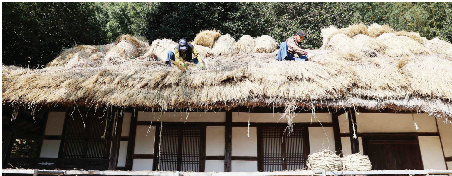
영랑생가 지붕 새단장 26일 강진군 강진읍 탐동마을 영랑 김윤식 생가(국가지정 중요민속문화재 252호)에서 주민들이 새로 만든 이엉으로 안채 지붕을 이는 작업을 하고 있다.초가이엉 작업은 전통 기술을 보존하는 차원에서 지역 주민들이 참여하고 있다. (사진=강진군 계몽)
