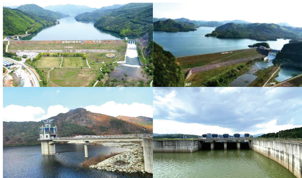
광주·전남지역 농업용 핵심 수리 시설인 4대호 전경. 시계방향 순서로 장성호·나주호·광주호·담양호. (사진=농어촌공사 제공)
