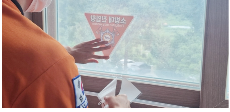
진도소방, 피난약자시설 화재예방 안전컨설팅 실시 진도소방서(서장 김광선)는 최근 향적사 등6개소 대상으로 피난약자시설 화재예방 안전컨설팅 실시했다고 밝혔다. 진도=조상용 기자
