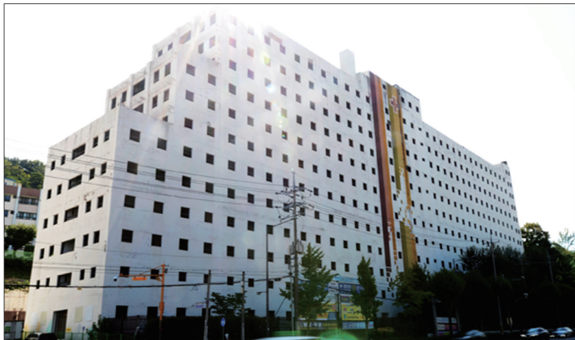
공사 중단 이후 장기간 방치된 건축물이 전남 15곳, 광주는 9곳인 것으로 파악됐다.
