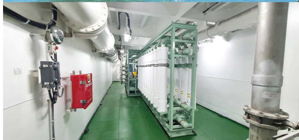
환경부가 건조한 이동형 해수담수화 플랜트 선박 드림즈호가 목포 연안을 항해하고 있다. (사진 위) 드림즈호 내부 설비 모습. (사진 아래)
