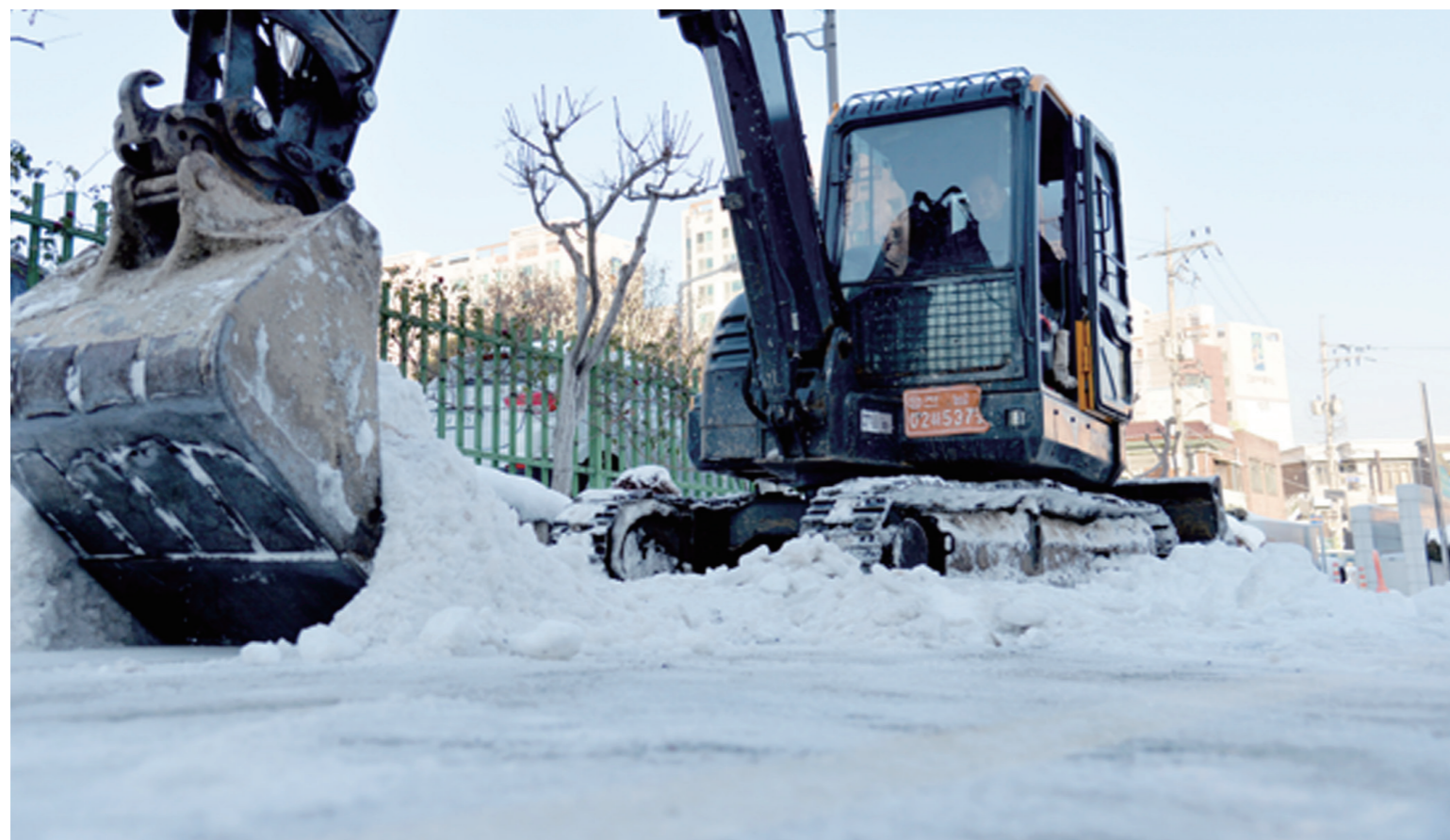
얼음 주차장 제설작업
