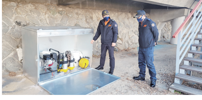
광주 동부소방, '제한급수 위기 극복' 비상흡수장비보관함 설치 광주 동부소방서(서장 송민영)는 극심한 가뭄에 따른 제한급수 등으로 소방용수 부족사태를 대비하기 위해 광주천에 비상흡수장비보관함을 설치했다고 밝혔다. 이슬비기자
