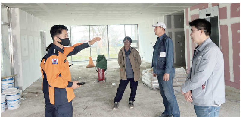
강진소방, 건설현장 대형화재 예방위한 현장방문 안전컨설팅
