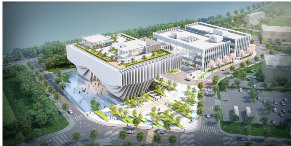
Park 1538광양 조감도 모습. 해당 부지에는 광양제철소의 경쟁력과 친환경 철강 브랜드를 알릴 홍보관(왼쪽)과 인재육성을 책임질 교육관이 들어선다. (사진=포스코 제공)
