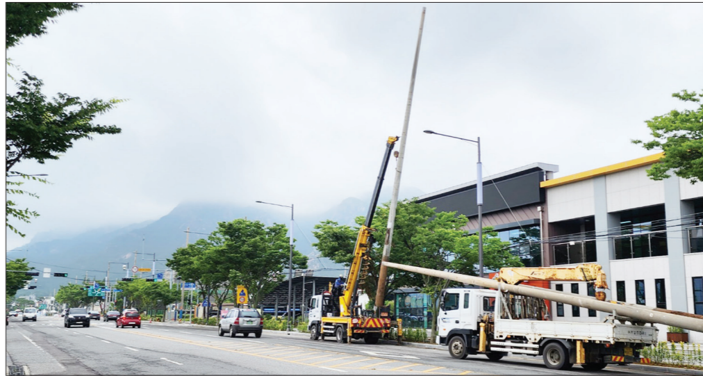
중화사업을 마무리할 계획이다. 영암군 관계자는 "안전사고 없이 지중화사업을 완료해 도시미관과 보행환경 개선, 주민 생활안전 증대 등을 이뤄내겠다"며 "주민 불편
