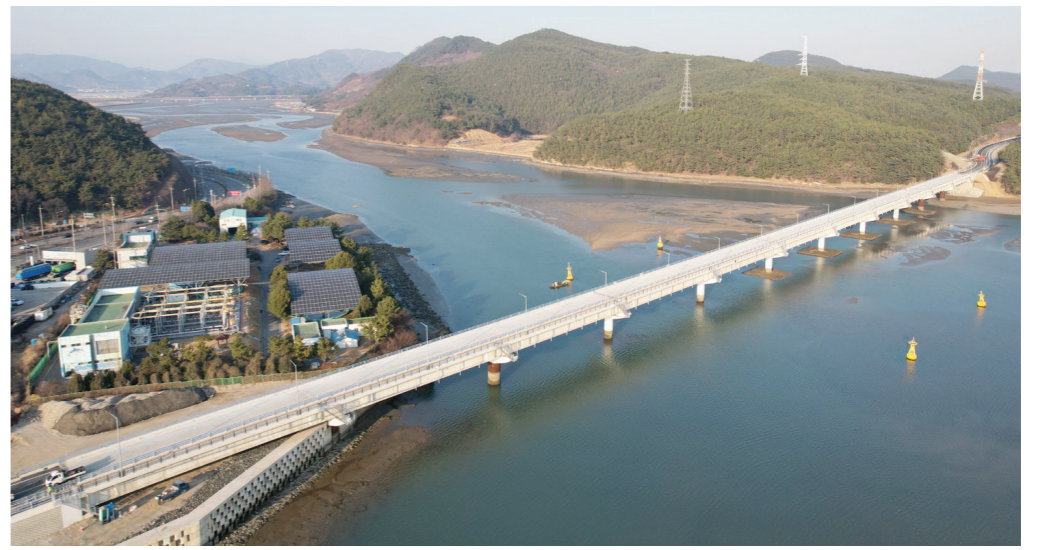
전남 광양시 진월~광영간 지방도 확포장 공사. (사진=전남도 제공)
